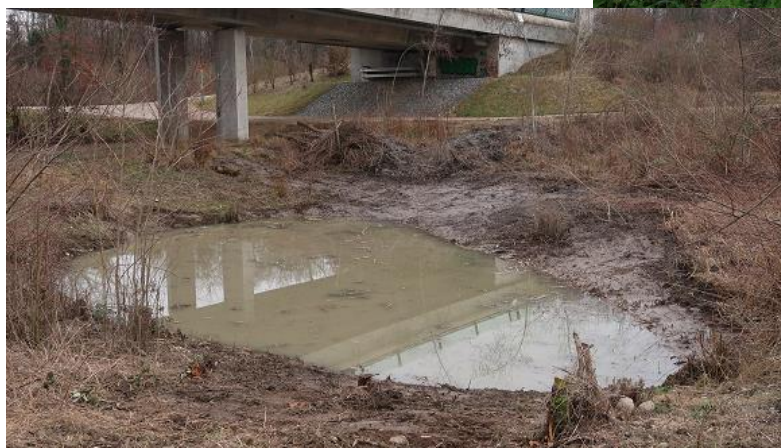
Bild nach der Sanierung Winter 2020/21
