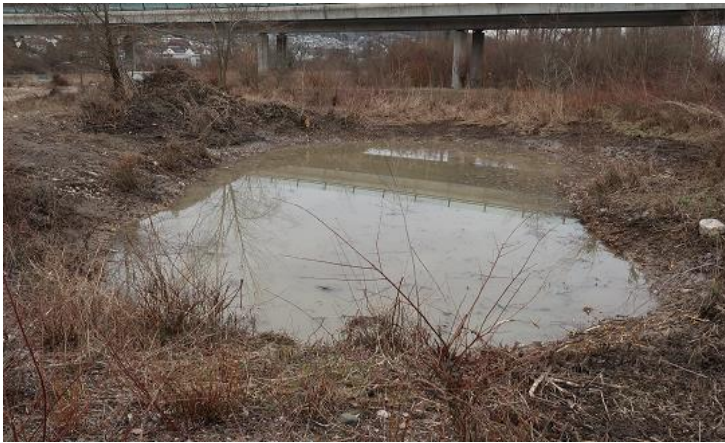
Bild nach der Sanierung Winter 2020/21
